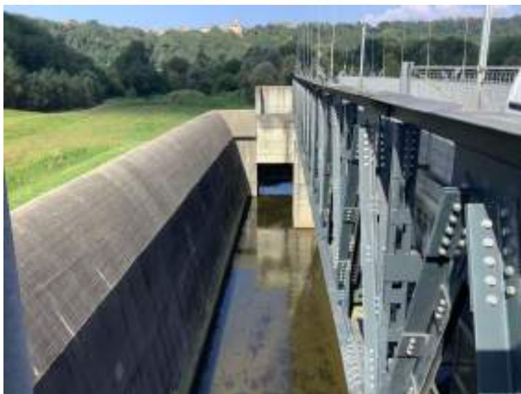
Figura 7 - Manufatto di regolazione (vista da coronamento). Sono visibili la soglia sfiorante di superficie e lo scarico di fondo regolato sul lato sinistro, la vasca interna di dissipazione e la passerella metallica di accesso.
