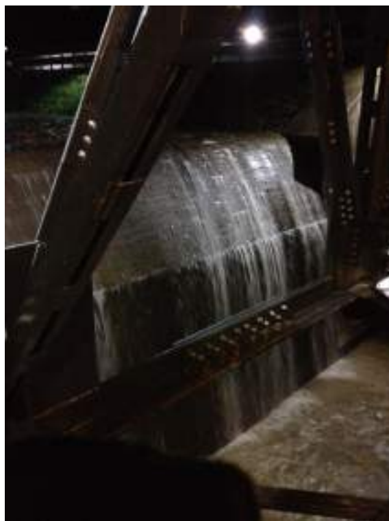
Figura 39 - Attivazione degli scarichi di superficie in conseguenza del raggiungimento della quota di massima regolazione dell'invaso (289,30 m s.l.m.) durante l'evento di piena del 26 dicembre 2013. Fonte: GVPC di Malnate.
