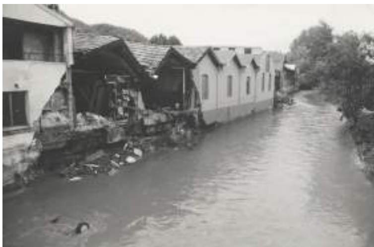
Figura 25 – Muri dello stabilimento Metalplast di Torba a Gornate Olona demoliti dall’urto dell’onda di piena del Fiume Olona. Fonte: Archivio CNR IRPI Torino.
