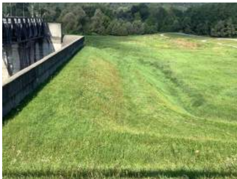
Figura 4 - Particolare del paramento di monte con i rinfianchi di materiali sciolti sagomati.
