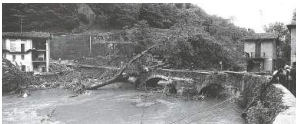
Figura 26 -Abitazione in località Mulini di Castiglione Olona parzialmente demolita per erosione spondale e Ponte Medioevale danneggiato dall’impatto di detriti e alberi provenienti dalla scarpata destra. Fonte: Archivio CNR IRPI Torino.
